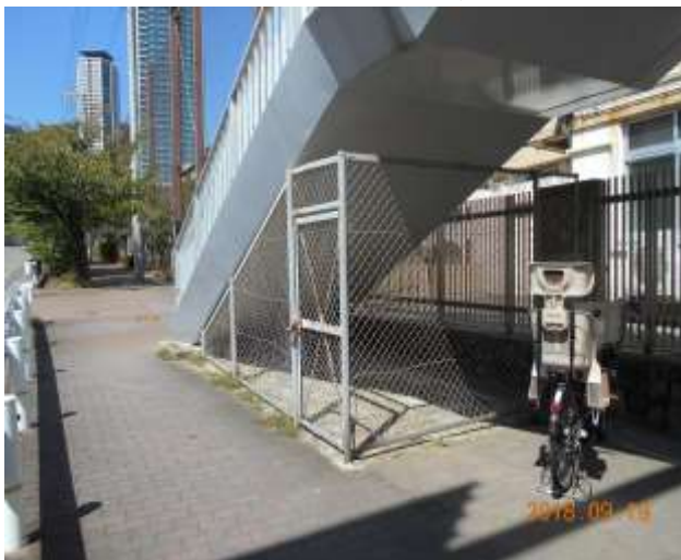
柵で仕切られた歩道橋
