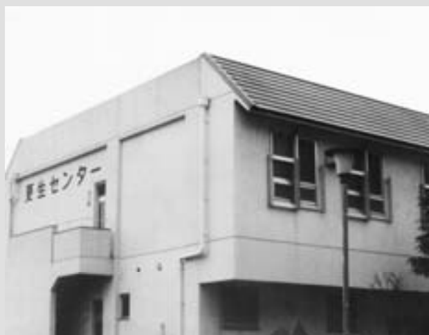
（写真）更生センターの外観
