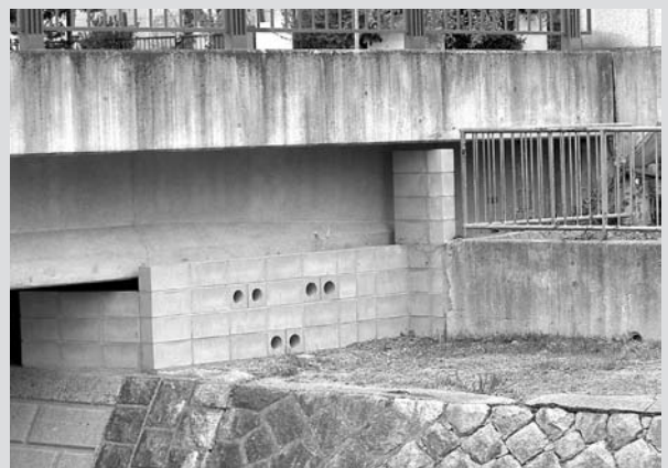
（写真2）橋の下を閉鎖するブロック塀。2007年11月
