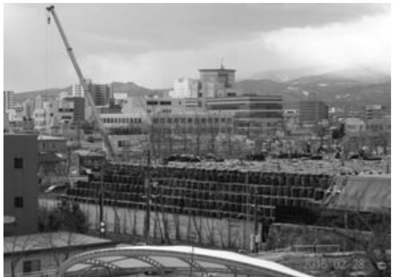
福島市中心部の仮置き場は今月中で搬入終了、手前の公園から見る
