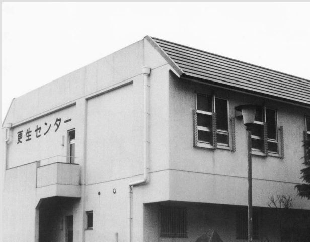
（写真）更生センターの外観
